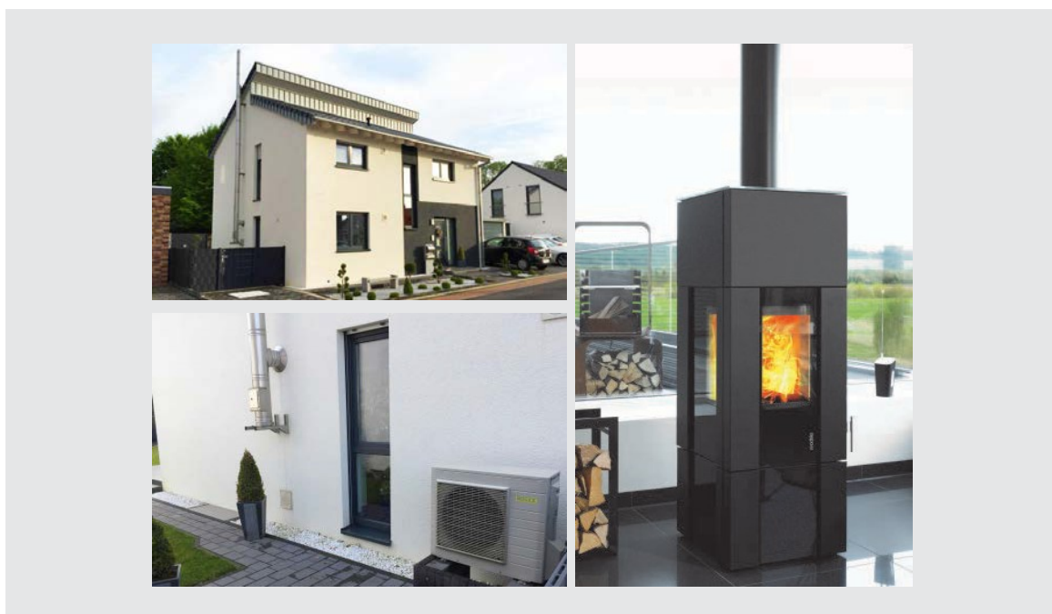
Slika 8: Primer 1 - toplotna črpalka zrak- voda in enosobna kurilna naprava, neodvisna od zraka v prostoru, s kovinsko dimovodno napravo iz nerjaveče pločevine
